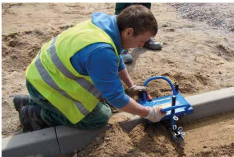
Es wird verwendet, um die Oberfläche am Bordstein zu nivellieren, an Stellen, wo eine Entwässerungsrinne unter der Entwässerung gebildet wird. Die Schiene ermöglicht die Einstellung der Höhe und Breite der Arbeit auf die gewünschte Dimension.
