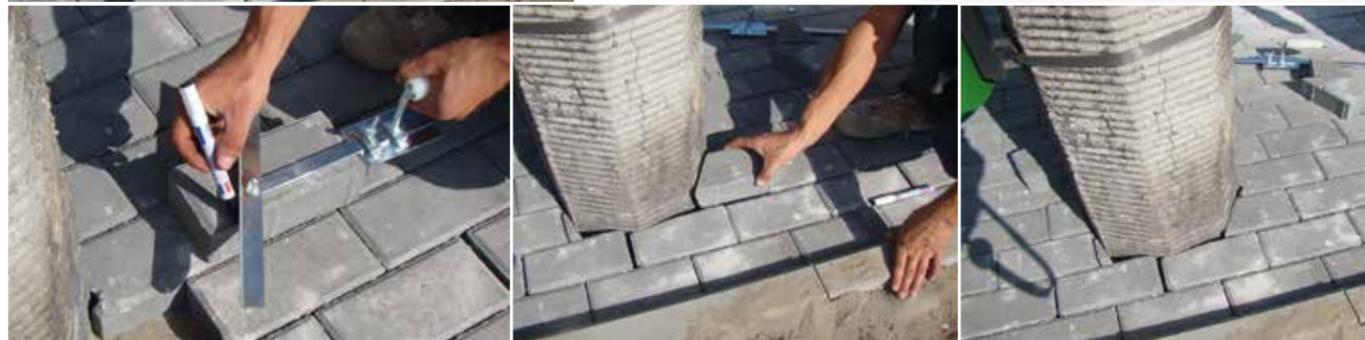
Ein ausgezeichnetes Gerät zum Bestimmen (Ausrichten) der Winkel beim Schneiden der Pflastersteine. Das Messgerät beschleunigt sogar die mit der Vorbereitung des Bodens und dem Verlegens des Pflasters verbundenen Tätigkeiten um bis zu drei Mal.
